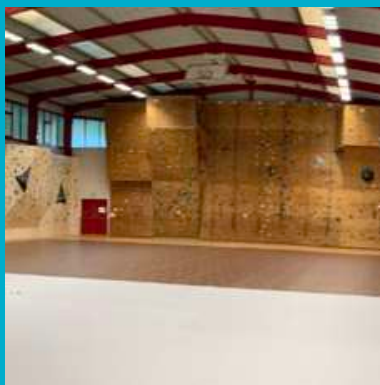
Rénovation du gymnase du Collège Auguste Blanqui à Puget-Théniers
