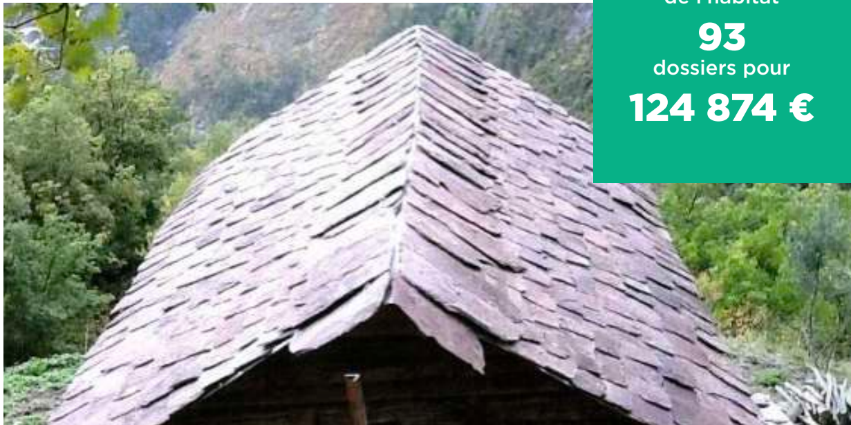
Rénovation de toiture à Roure © CAUE
