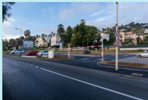
Parking de covoiturage « Pont de l'Aube » à Vallauris RD 6007
