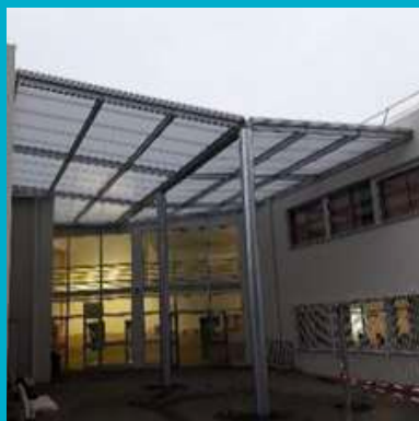
Construction de deux préaux au collège André Malraux à Cagnes-sur-Mer
